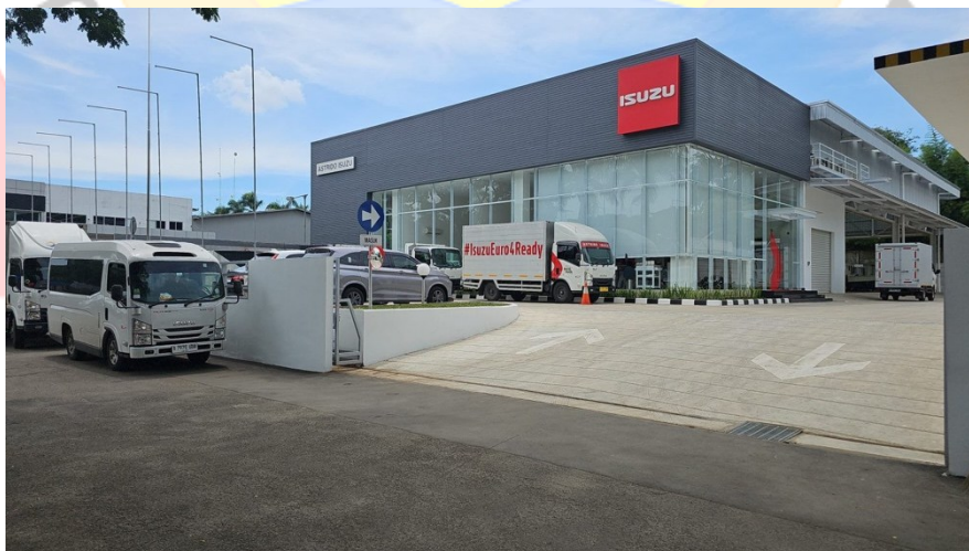
Gambar 1.4 Tampak depan perusahaan
