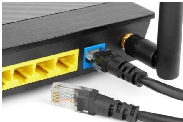
Gambar 3.8: Mencabut kabel pada wireless router (Koubou, 2021)
